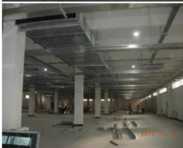
中国:大連工場 増床工事中
