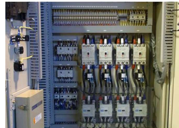
装置制御盤製作
